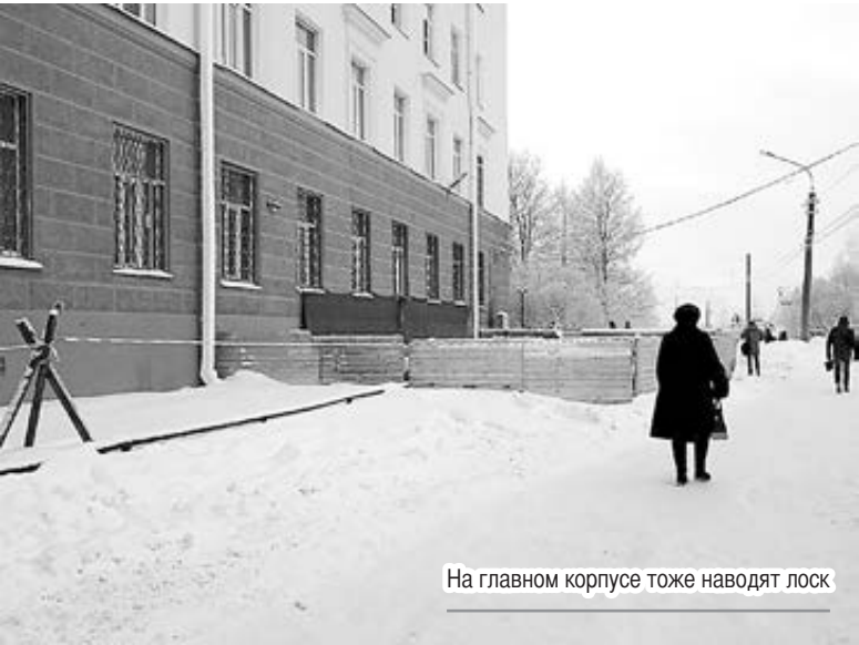
Косметический ремонт в разгаре
