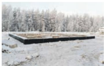
В Пинежском леспромхозе началось строительство нового кафе для сотрудников предприятия. Это будет одноэтажное каркасное здание с полным комплектом необходимых помещений и залом на 70 посадочных мест. На сегодня произведен монтаж сборного железобетонного фундамента и опорных плит. Сдача объекта в эксплуатацию запланирована на июнь 2019 года.
